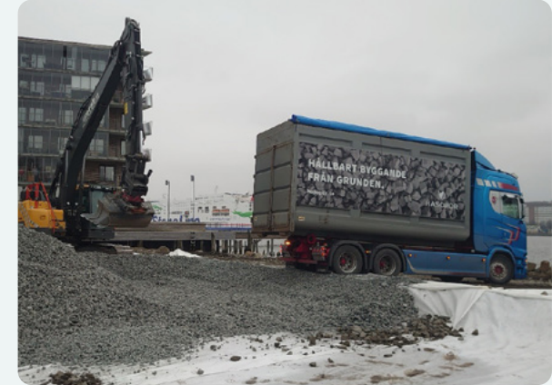
Laajan ja haastavan rakennusprojektin pohjatyöt ratkaistiin vaahtolasimurskeella.
