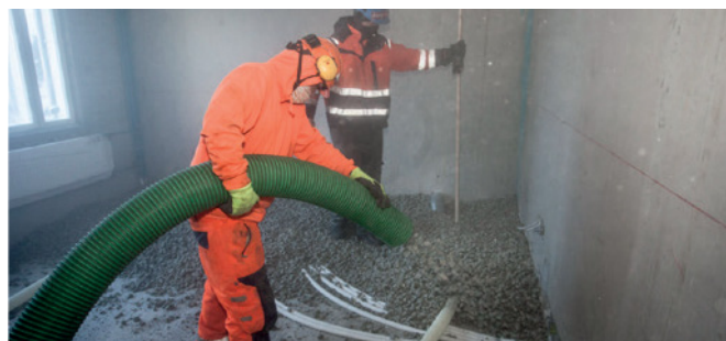
Väestönsuojan päällisen täyttö
