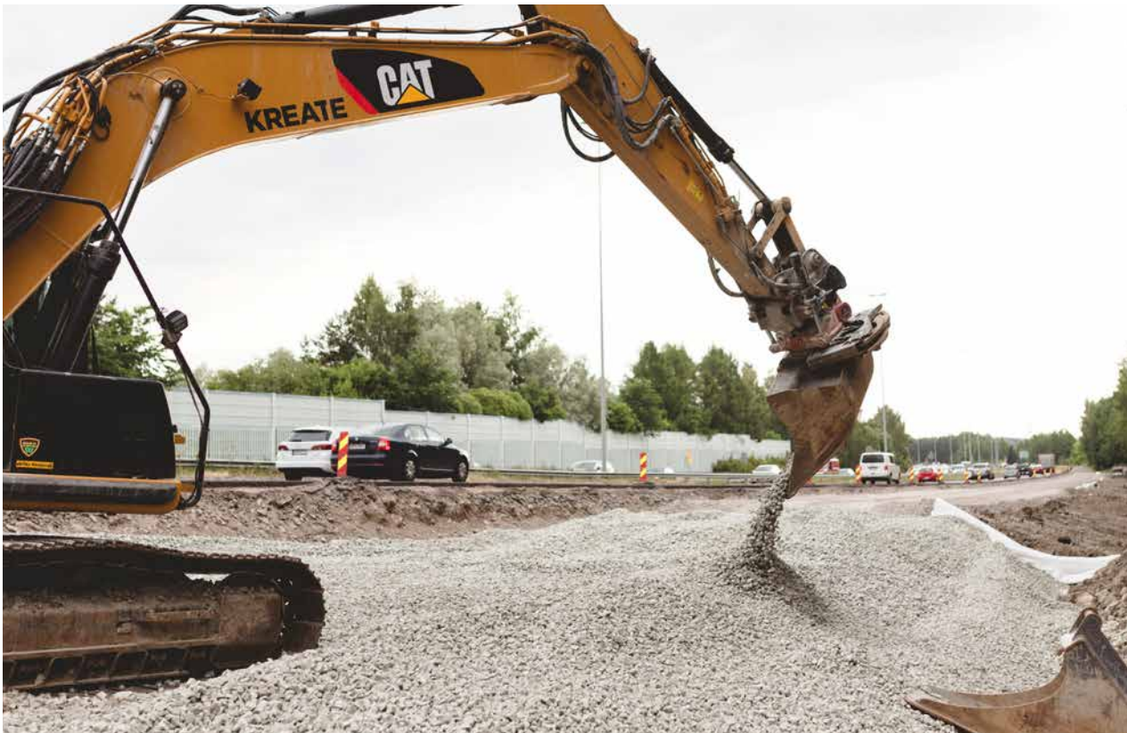
Kuva 5.1. Tien leventäminen Foamitilla kevennettynä.
